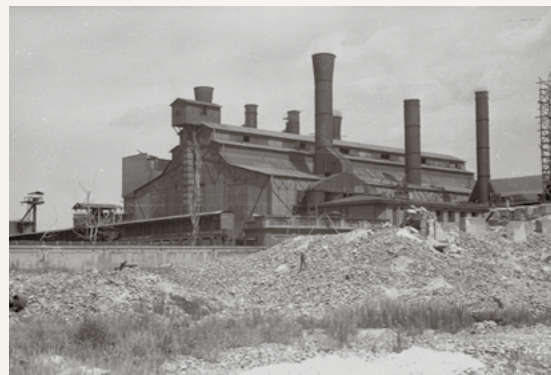
Images: Minus Osiem, Radek Gałczyński, Elektrownia Powiśle, Warsaw, Poland
